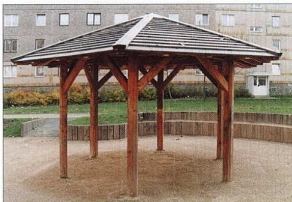
Pavillon (aus Lärchenholz) stabile Bauweise für den kommunalen Bereich
