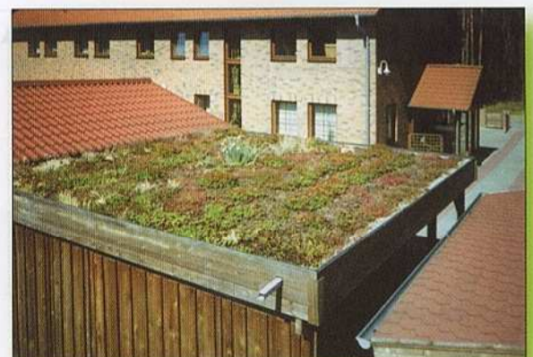
Doppelcarport mit extensiver Dachbegrünung (3. Jahr)
