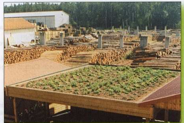
Doppelcarport mit extensiver Dachbegrünung (1. Jahr)
