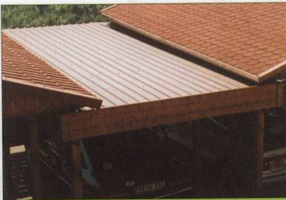
Sonder- Flachdach-Carport mit Standard- Trapez-Profilblech
