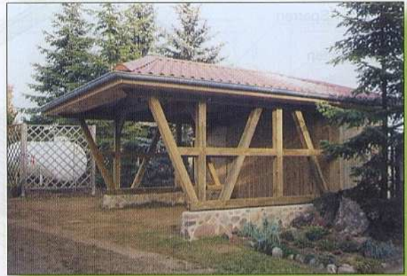
Fachwerk-Carport mit Walmdach und integriertem Geräteraum
