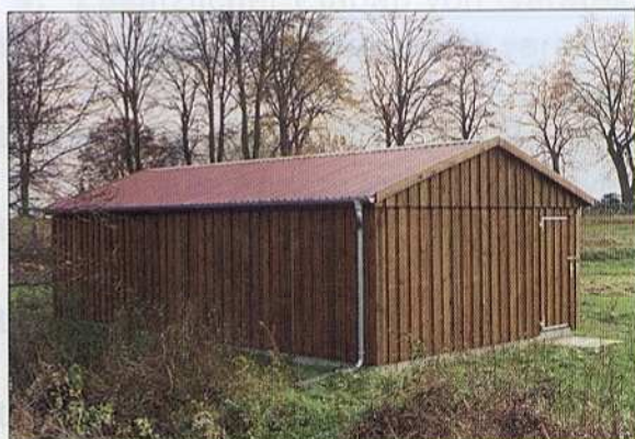
Gerätehaus in Sonderanfertigung (isoliert), mit Satteldach
