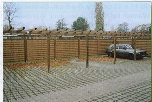
Offene PKW-Stellplätze in Arkadenbauweise mit Rückwand
