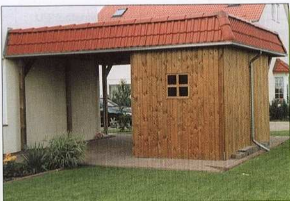
Einbau-Gerätekammer, Sonderanfertigung mit Sprossenfenster
